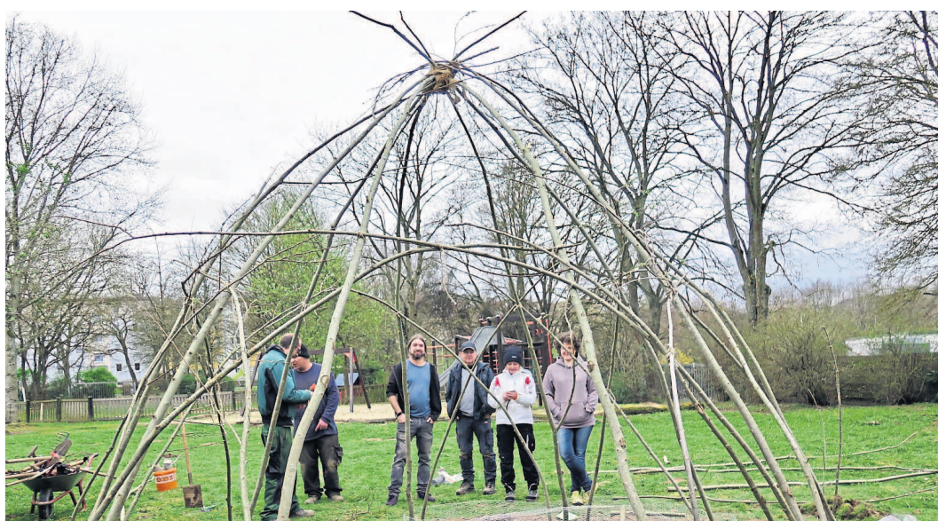
Die Weidenkuppelkonstruktion der Studentinnen Karolina Littwin und Anna Michalski wird hinter dem Kindergarten errichtet.
